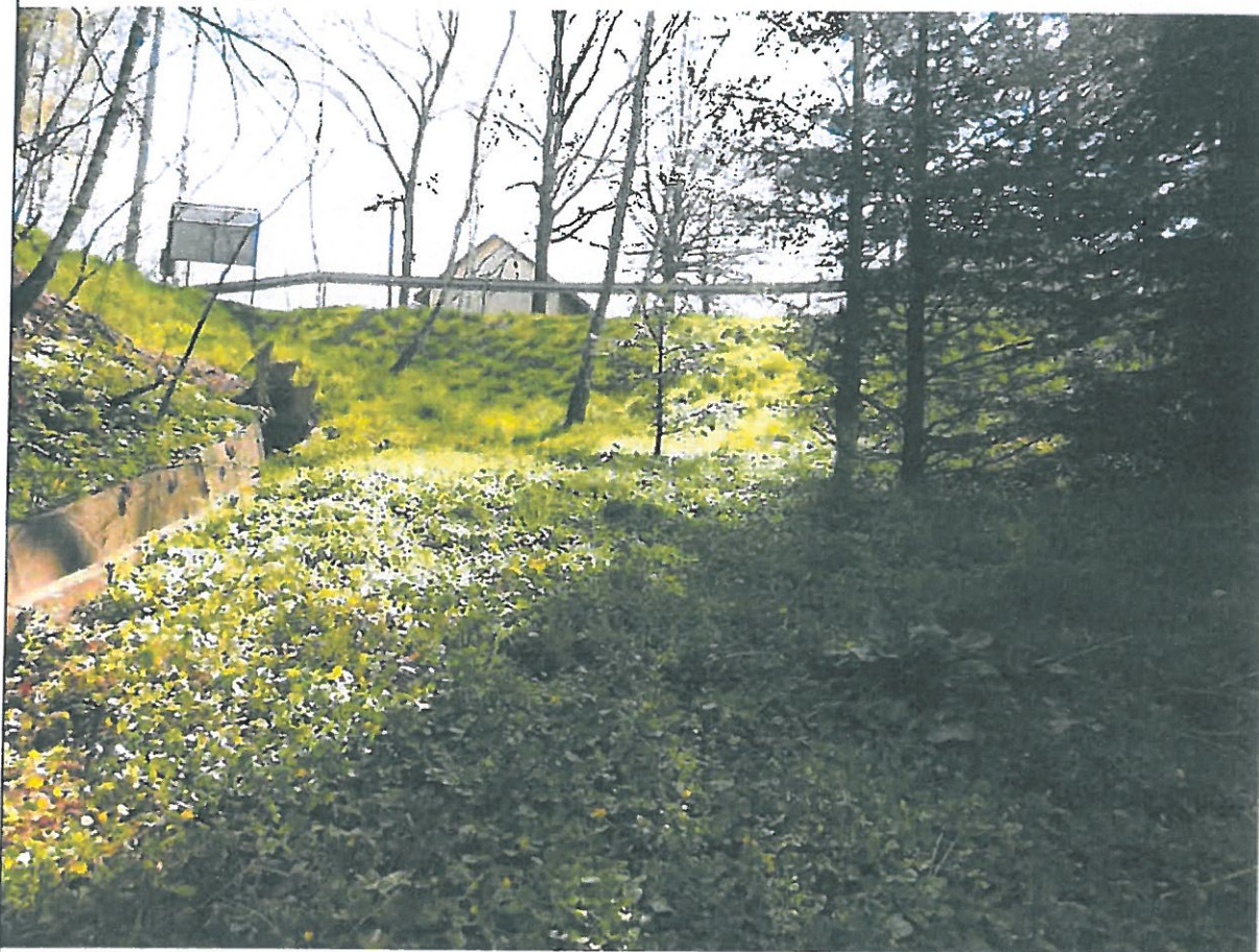
Widok na górną część osuwiska (po lewej stronie korytko odwadniające)
