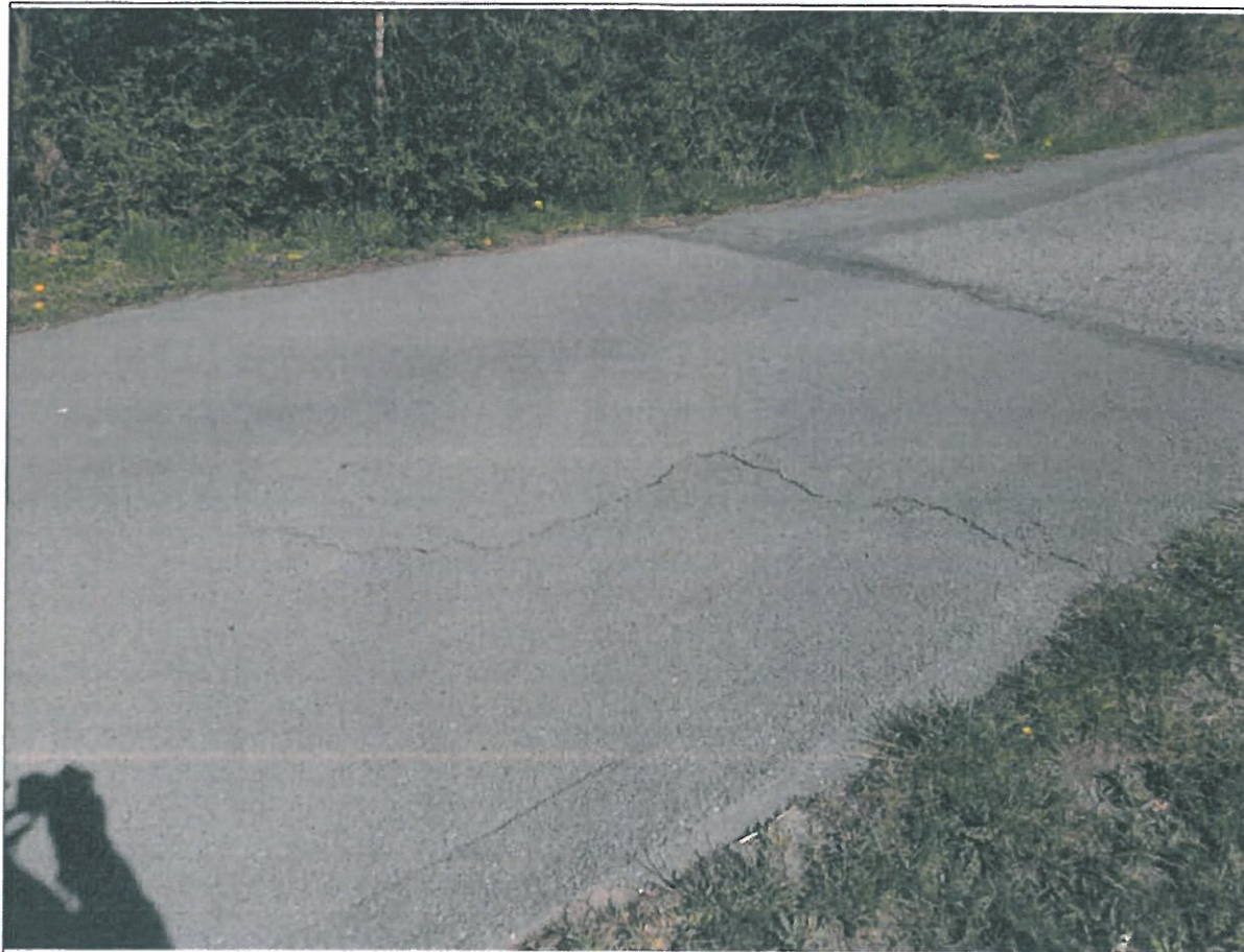
Szczeliny na załatanym odcinku asfaltu
